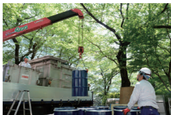
【写真】PCB 廃棄物を処分場へ運び出す様子
