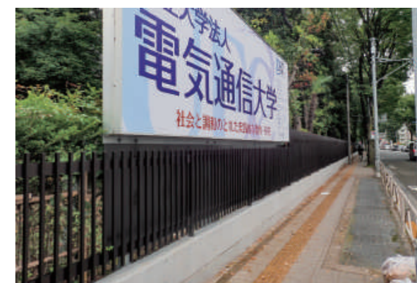
【写真】改修後の格子フェンス
