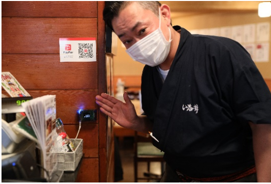
CO 2 センサーの設置事例
